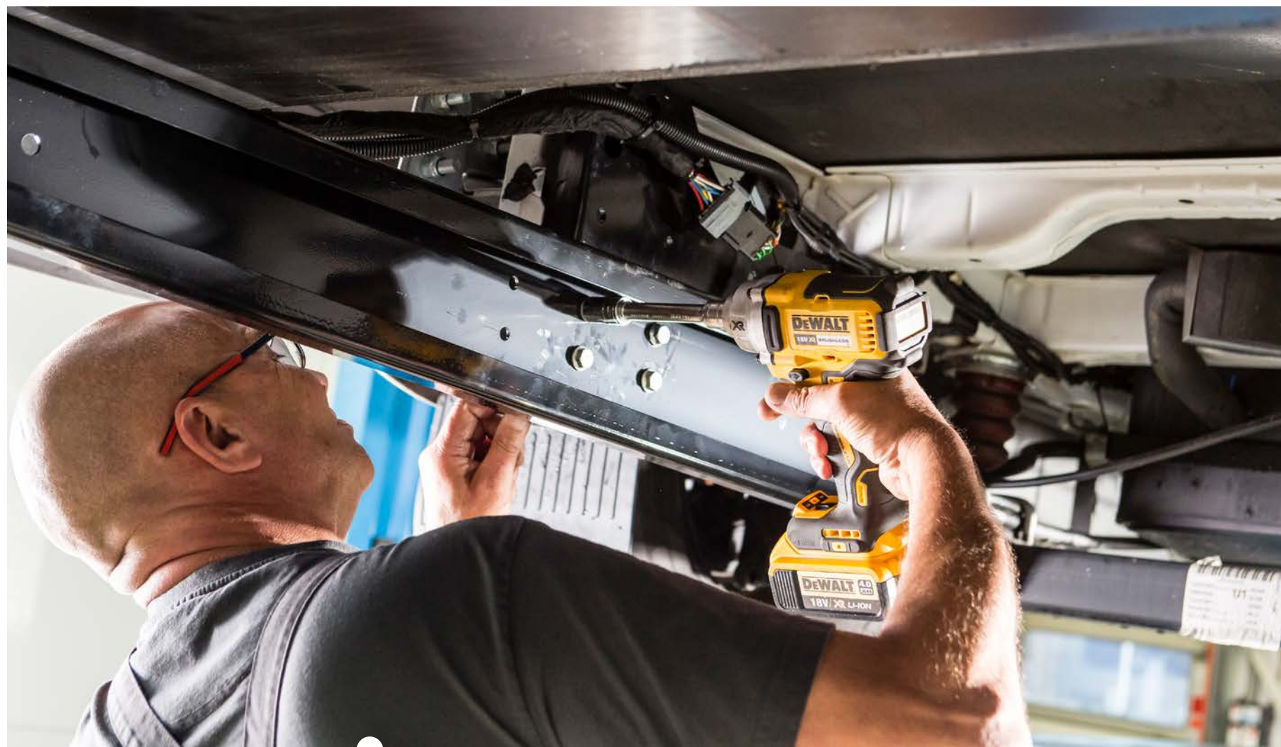
Met nog eens zes bouten zijn de lange extra chassisbalken aan de chassisadapters bevestigd
